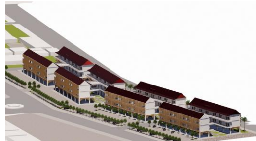
Gambar 5. Fasad Bangunan (Sumber: Konfigurasi Penulis, 2024)
