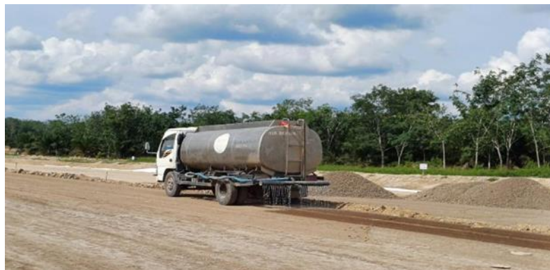
Gambar 5 Penyiraman Lokasi Proyek
