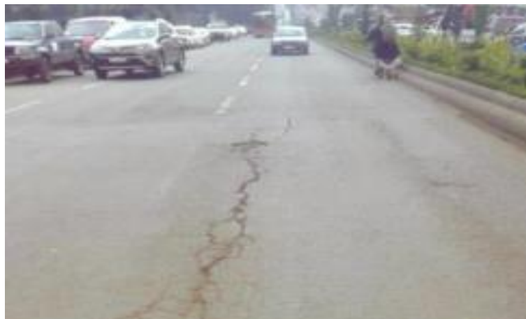
Gambar 3. Kerusakan Retak Memanjang.
