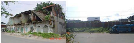
Kondisi bentuk bangunan bekas Keluarga M. Yatim yang sudah rata dengan tanah.
