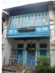
Gambar 13: Typologi Shophouse tipe II Sumber: Dokumentasi Penulis, 2017
