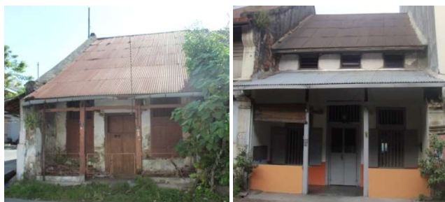
Gambar 12: Typologi Shophouse tipe I Sumber: Dokumentasi Penulis, 2017
