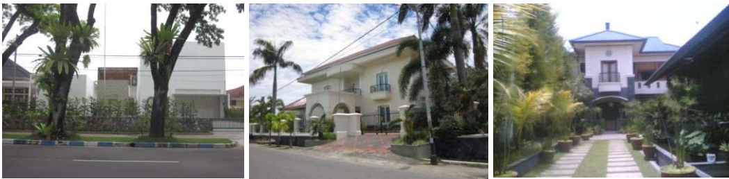
a. Rumah (R.1) b. Rumah (R.2) c. Rumah (R.3)
